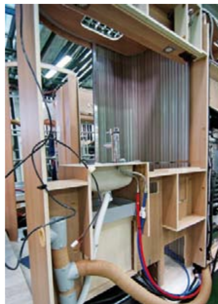
Valokuva kertoo hyvin, kuinka monimutkaistenkin kalusteiden ja varusteiden asentaminen onnistuu helposti, kun seinät eivät vielä ole paikallaan.
